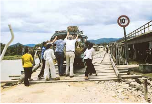
Die Brücke über den Roten Fluss wurde bis auf die Pfeiler zerstört. Durch das langsame Fahren auf den holprigen Bohlen bestand oftmals Gefahr, dass Gepäckstücke vom Dach herunterfallen würden.
