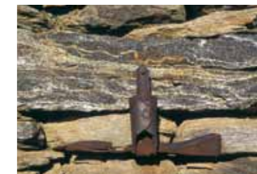
Ausgedientes Werkzeug wird in der Mauer verankert
