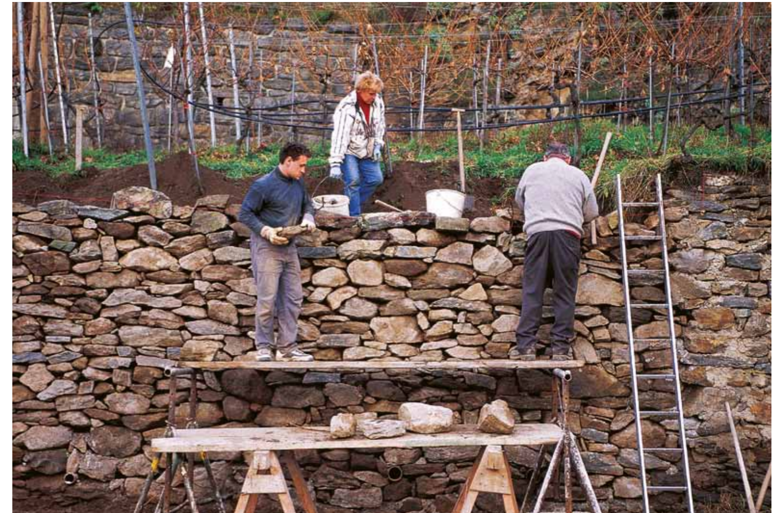
Wiederaufbau einer Trockenmauer
